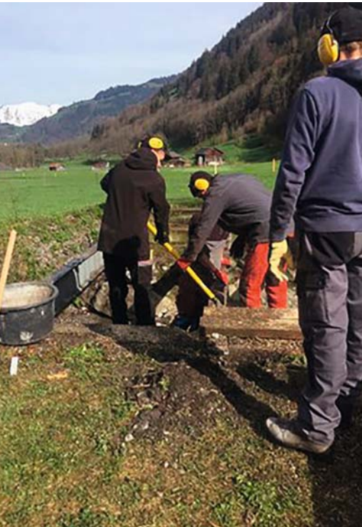
Brückenbau - beim Restaurant Wasserfall bauen Schüler und Schülerinnen eine neue Langlaufbrücke.
